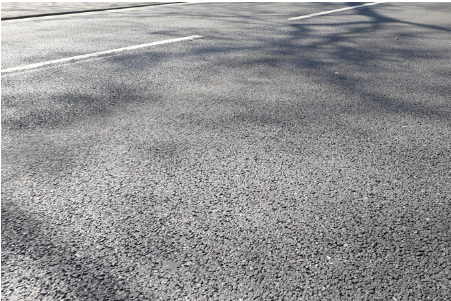
Detmolder Straße, Paderborn 2018
